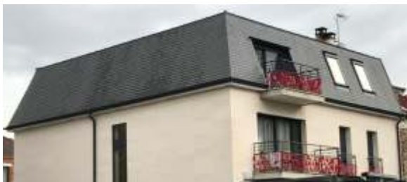
▶ Fachada em Relvinha
